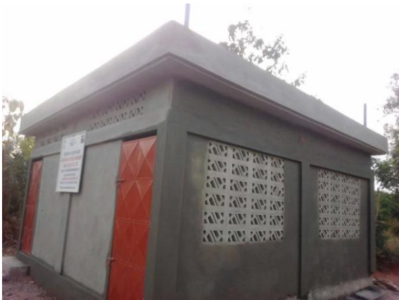
Bâtiment de 8 cabines de latrines
